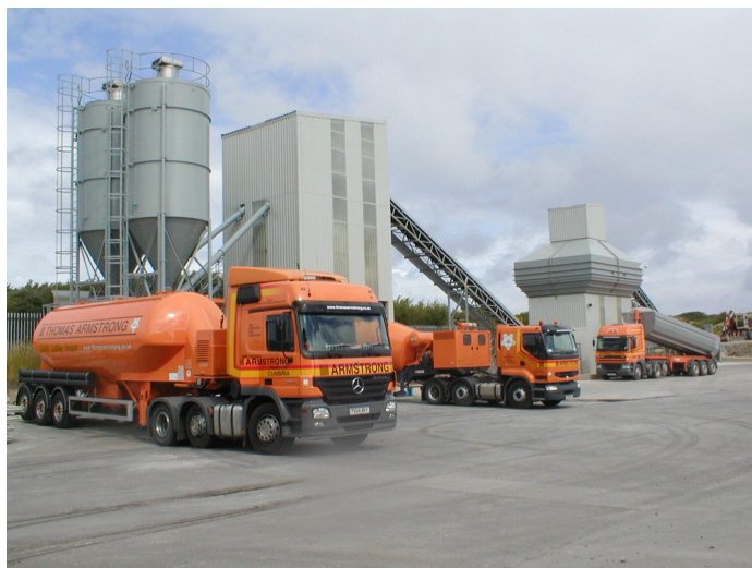
شکل ۱-۳- نمونه ای از کارگاه پیمانہ گیری و ساخت بتن
