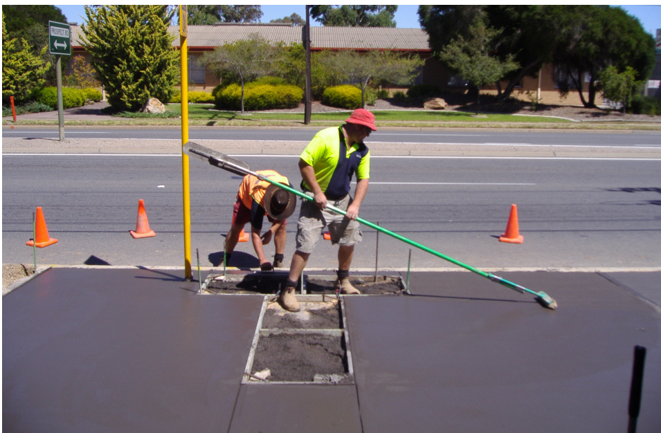
شکل ۴-۱- پرداخت سطوح بتنی
