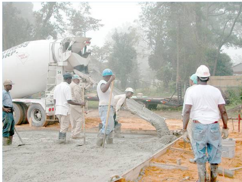
شکل ۳-۶- تخلیه بتن از تراک میکسر
