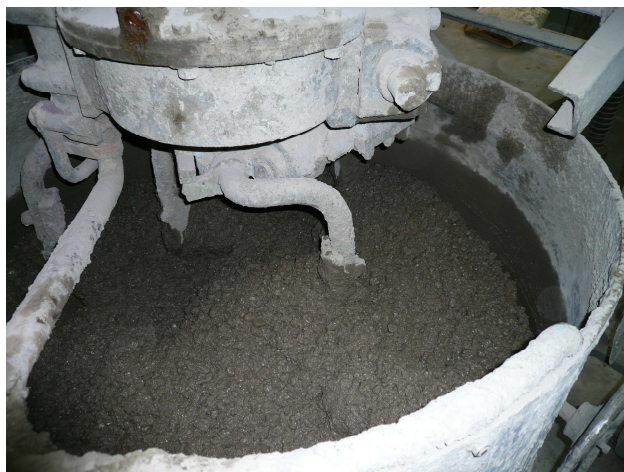
شکل ۴-۳ - چگونگی اختلاط بتن در میکسر
