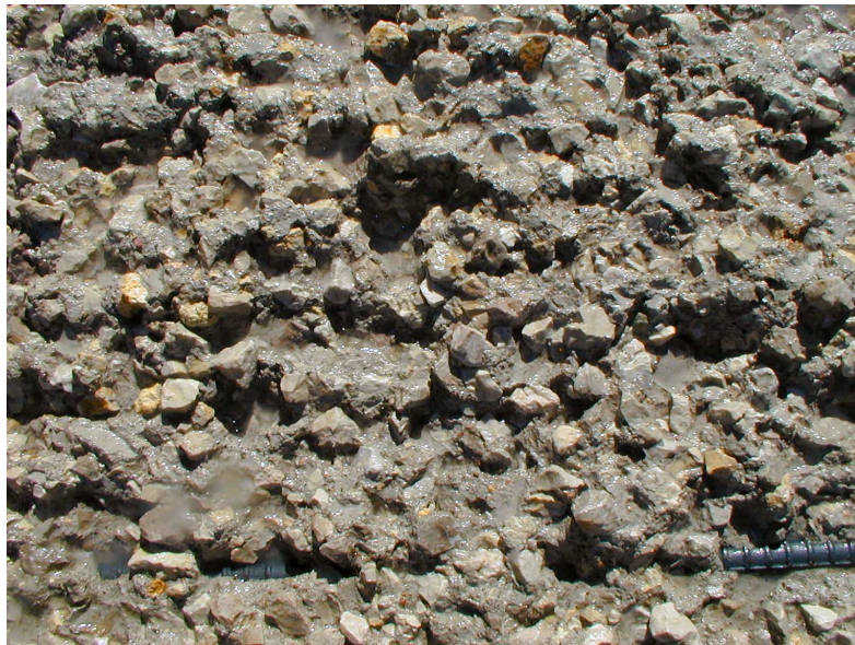
شکل ۷-۵- سطح زیر شده بتن
