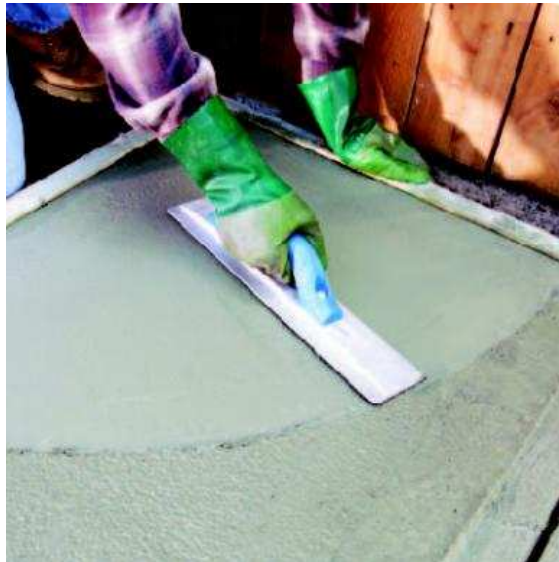
شکل ۷-۴- پرداخت بتن سبک
