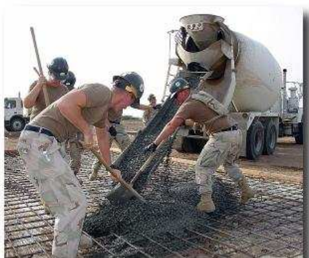
شکل ۸-۱- بتن ریزی توسط ماشین های حمل بتن
