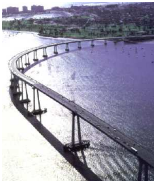
شکل ۱-۱۰- پل سبک در سن دیگو ایالت کالیفرنیا
