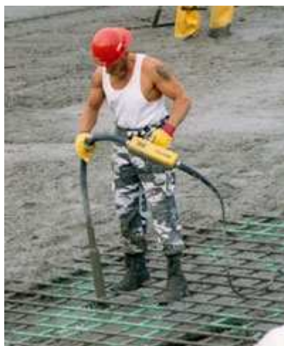
شکل ۷-۱- تراکم بتن با استفاده از وایبراتور قلمی
