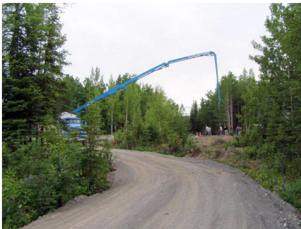
شکل ۵-۱- نحوه بتن ریزی با استفاده از پمپ
