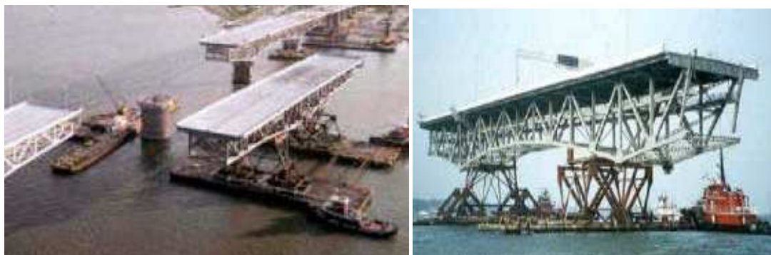
شکل ۱-۱۷- پل رودخانه Coleman
