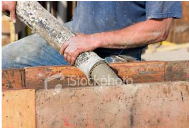
شکل ۵-۵- بتن روان شده با استفاده از فوق روان کننده
