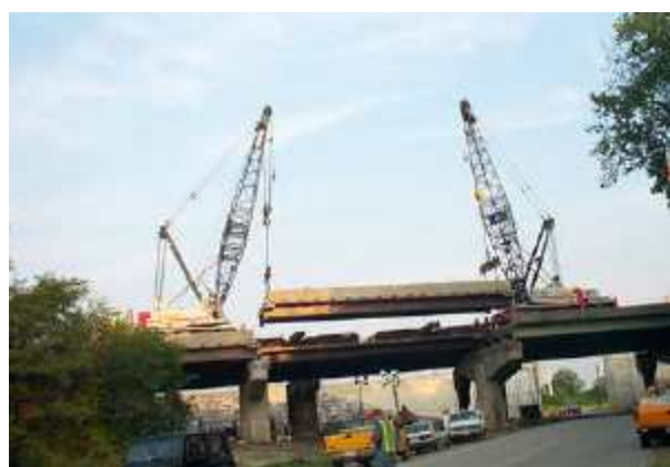
شکل ۱۵-۱- تصویر شماتیک و واقعی از نحوه اجرای عرشه پل رودخانه James
