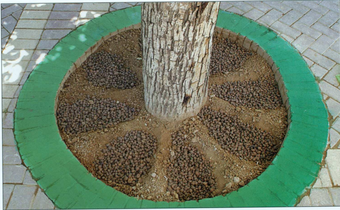
شکل ۳-۵ پرکردن شیرها با لیکا ۱۰-۲۰ میلیمتر
