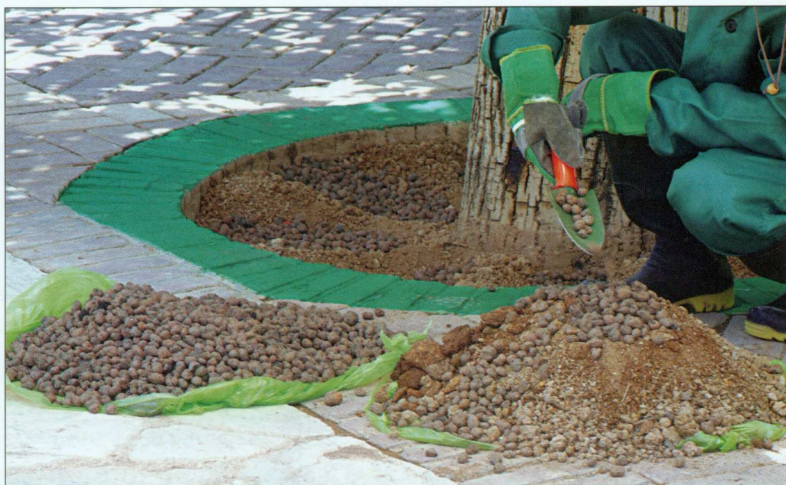
شکل ۳-۷ مخلوط کردن کود دامی و دانه لیکا و خاک زراعی به نسبت ۱-۲-۳
