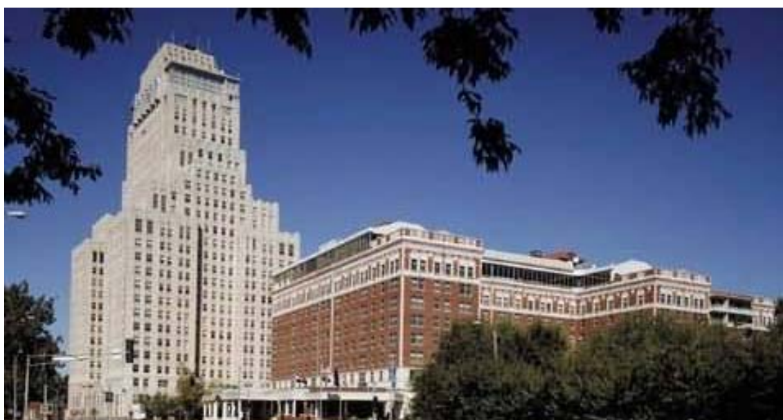
شکل ۳-۶- ساختمان هتل پارک پلازا در سنت لوئیز
