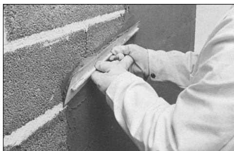
شکل ۲-۱۳- اندودکاری با استفاده از ملات سبک لیکا
