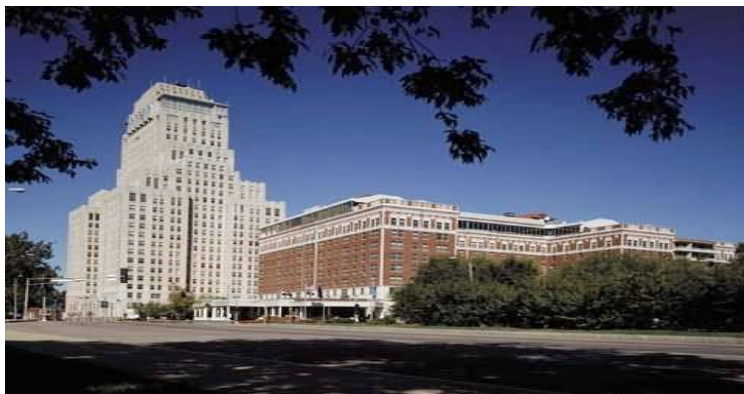
شکل ۱-۳- ساختمان هتل پارک پلازا در سنت لوئیز
